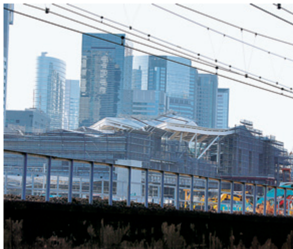
建設中の高輪ゲートウェイ駅(2019年1月現在)
